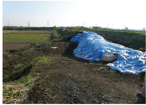
写真-14 破堤か所の仮復旧状況
