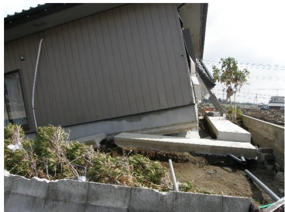
写真-8 基礎地盤の一部が流出して沈下・傾 斜した家屋(破提か所の近傍)
