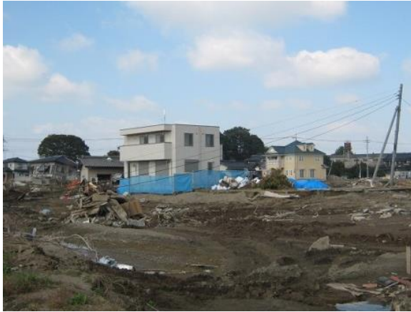
写真－9 流出せずに残存した家屋
