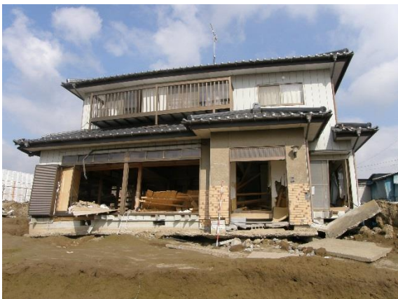
写真-7 基礎地盤が流出して沈下・傾斜した 家屋(破提か所の近傍)
