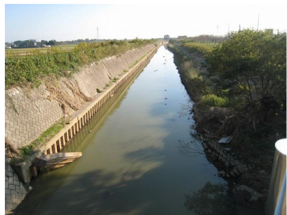
写真-16 相平橋から八間堀川の下流を望む (右岸側が越水か所)
