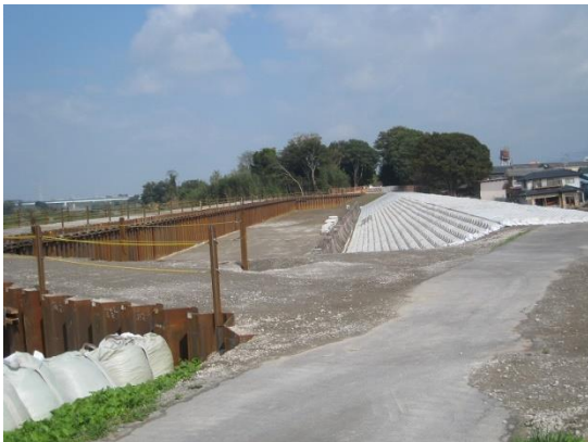
写真－1 破堤か所の下流から上流を望む （左側は二重締切工，右側が仮設堤防）
