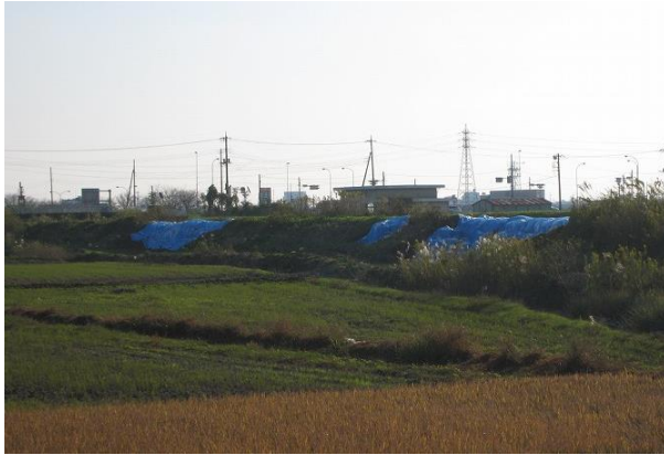
写真-13 八間堀川左岸の破堤区域全景
