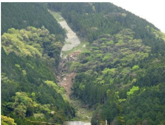
K_27 : 治山工事の末端の崩壊。
