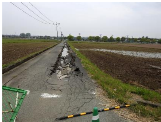
K_04：堤防や田んぼの中の道路では，液状化の痕跡が多数みられる。
