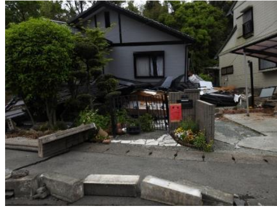
K_08：比較的新しい建物でも全壊した例もある。右隣の家は外見上は問題がない。
