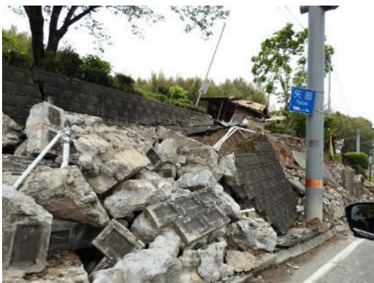
K_11：復旧に当たりガレキは積み上げられている。ここは裏込めがきれいに崩落している。
