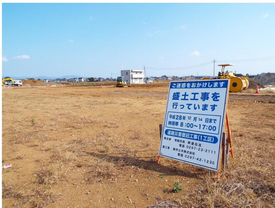
写真-2.8 県道357号線の東側の盛土造成工事
