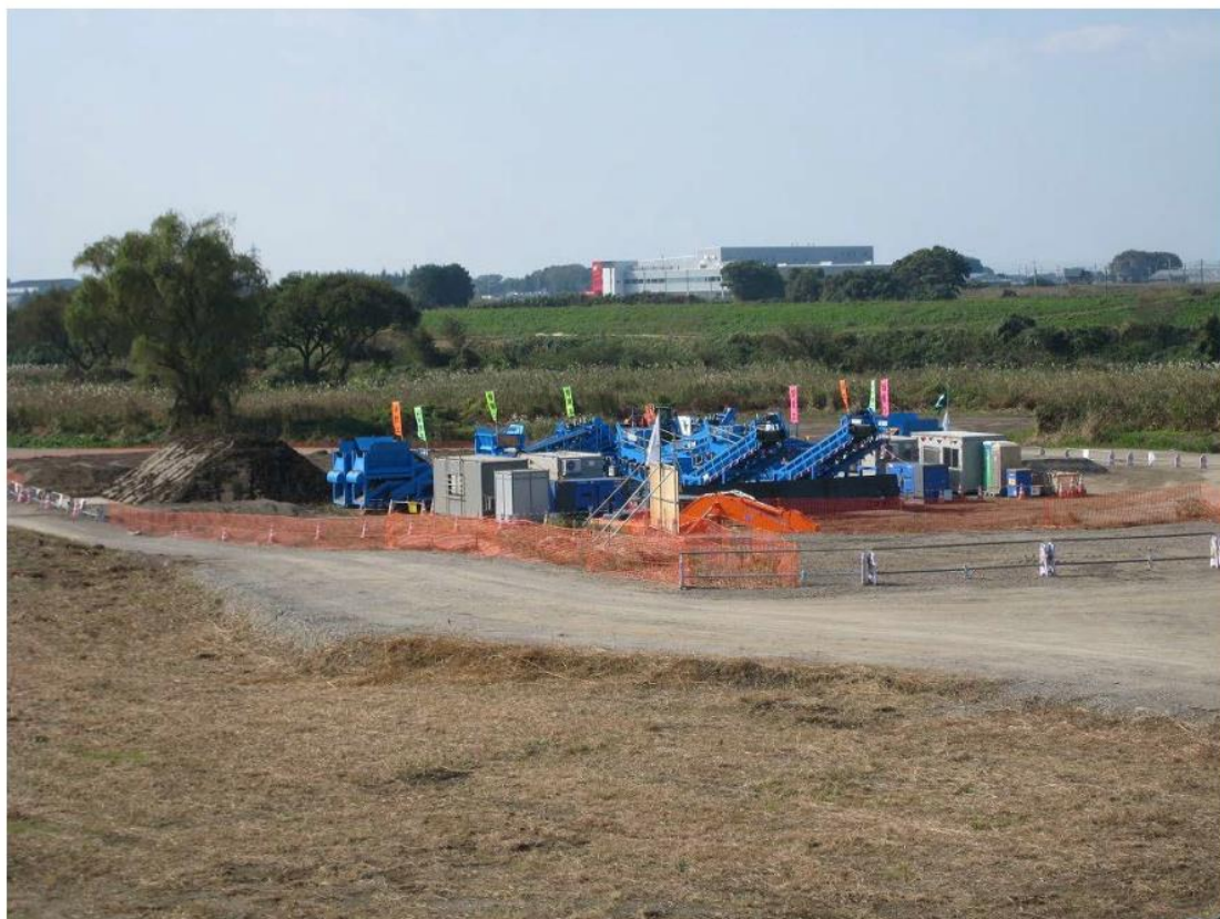
写真－2.2 堤体盛土用材料の選別施設（粘性土用）
