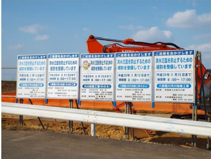
写真－4.1 八間堀川河川改修工事の立て看板
