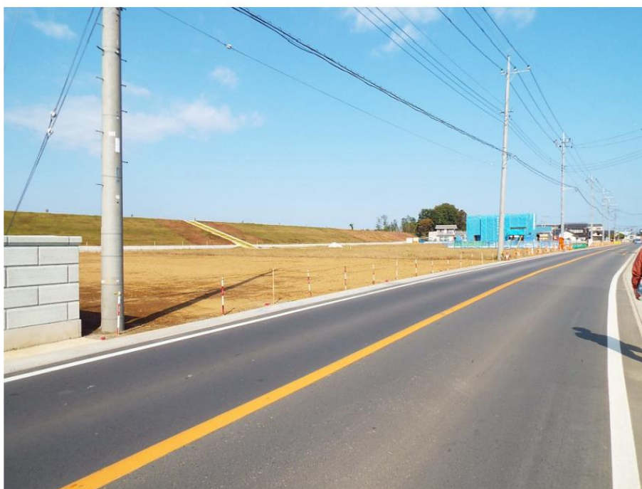
写真－2.7 埋め戻された堤防決壊箇所の堤内地
