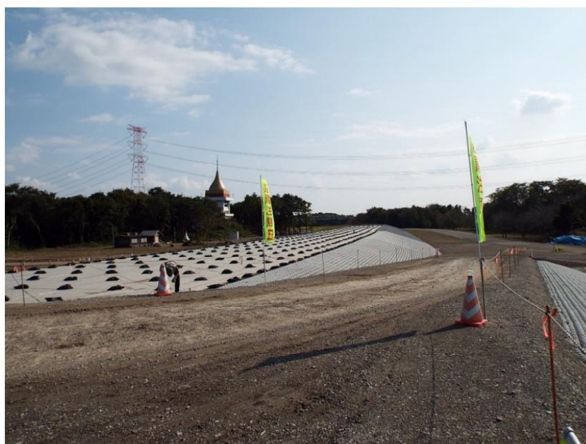
写真-3.4 堤防溢水箇所の下流側に新設された鬼怒川左岸堤防
