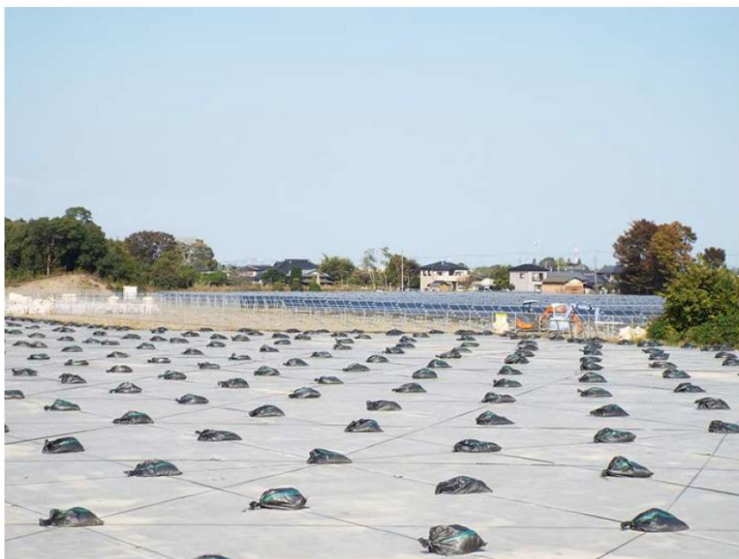
写真-3.3 堤防溢水箇所の左岸堤防天端（堤防から堤内地を望遠で撮影）
